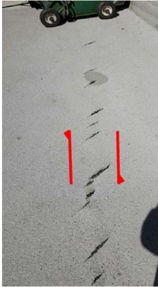
Fig. 5.8: En-échelon-cracks
